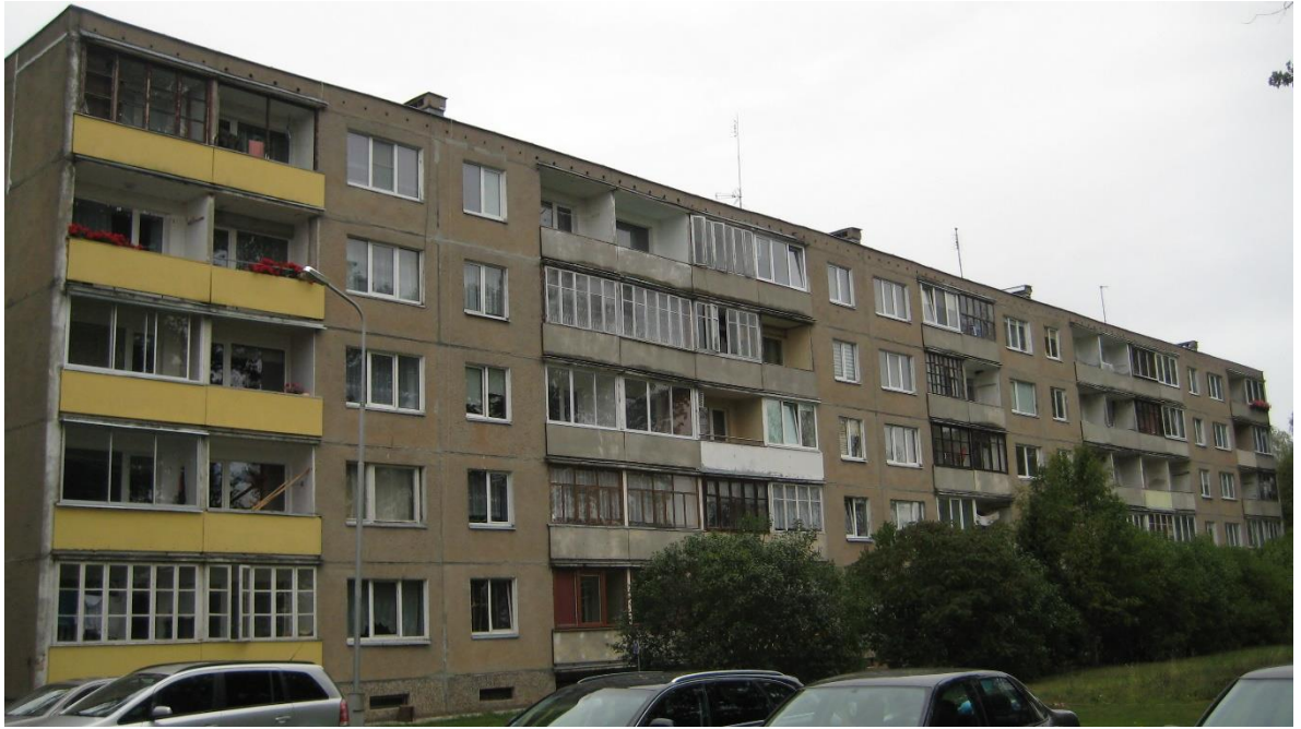
7 pav. Pastato fasado su lodžijomis / balkonais fragmentas.
