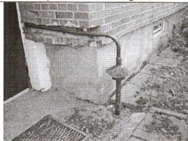
Atgrinda apaugusi samanomis, plytelės išsikliape, cololis paveiktas drėgmės
