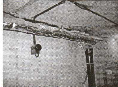
Karšto vandens magistralių izoliacija remontuota
