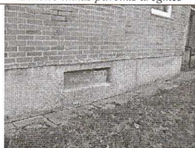
Atgrinda apaugusi samanomis, plytelės išsikliape, cololis paveiktas drėgmės
