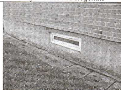
Atgrinda apaugusi samanomis, plytelės išsikliape, cololis paveiktas drėgmės
