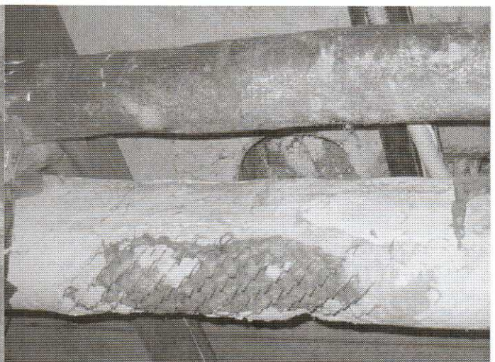
4. Inžinerinių sistemų būklės fragmentas.
