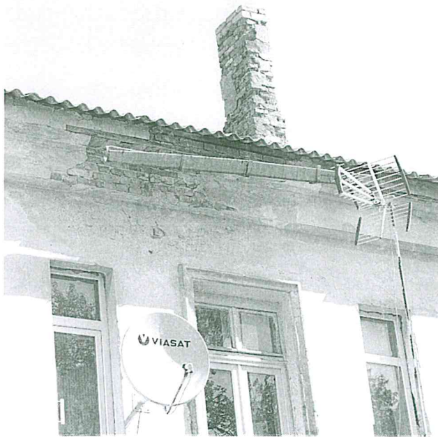
5 pav. Pastato stogo ir lietaus šalinimo sistemos būklės fragmentas.
