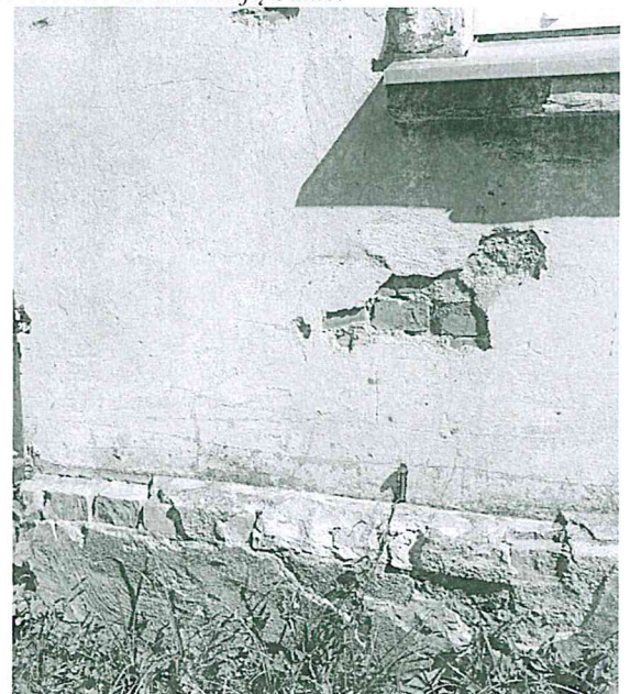
10 pav. Fasado ir cokolio apdailinio tinko būklė.
