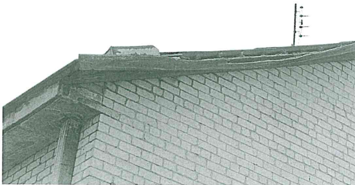
7 pav. Stogo pakalimo būklės fragmentas.
