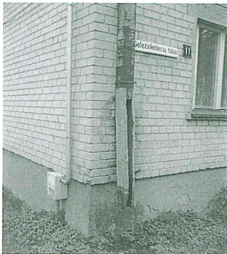
3 pav. Pastato lietaus šalinimo sistemos fragmentas.
