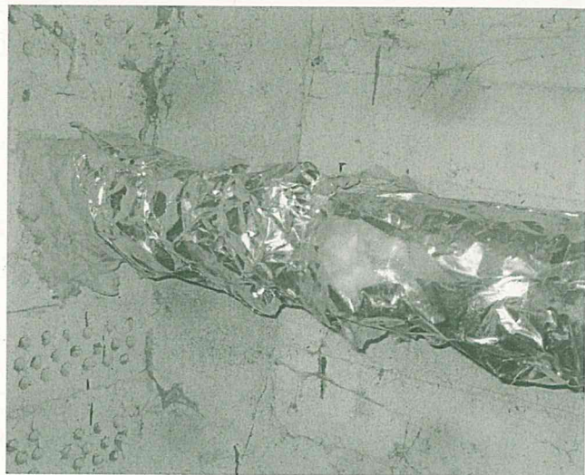
2 pav. Šildymo sistemos izoliacijos būklės fragmentas.
